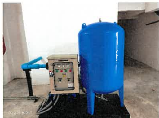
บูสเตอร์ปั๊มควบคุมแรงดันที่จ่ายน้ำจากชั้นดาดฟ้า
